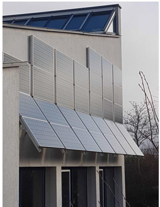
**Die Photovoltaikanlage an der Süd-Fassade der Philippuskirche lieferte seit 1998 einen Ertrag von über 50.000 kWh.**
