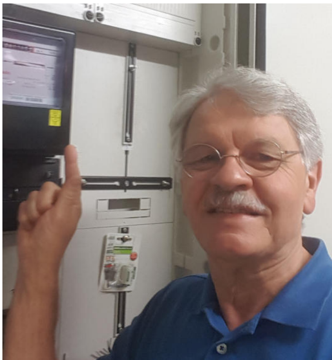
Heinrich Kilian beim Ablesen des Zählers der Photovoltaikanlage: die Einsteigeraufgabe als Umweltbeauftragter
